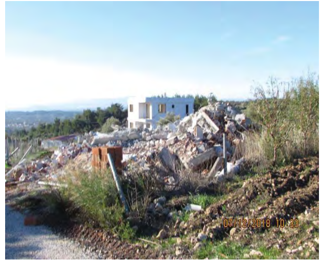
775 Sayılı Kanun Kapsamında Belenbaşı Köyü Yıkım Çalışması
