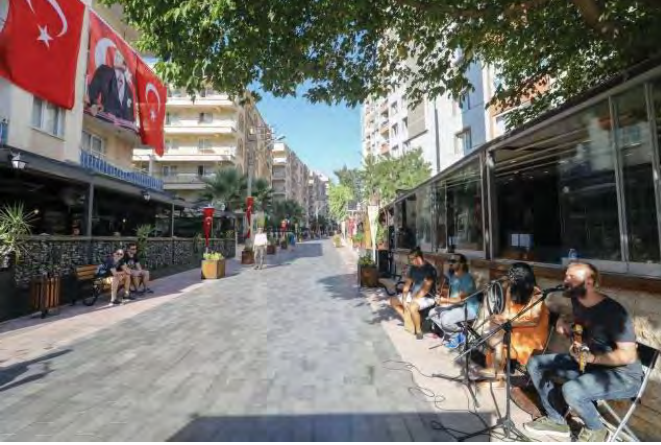
Adatepe Sevgi Yolu Yapımı 4/1 Sokak
