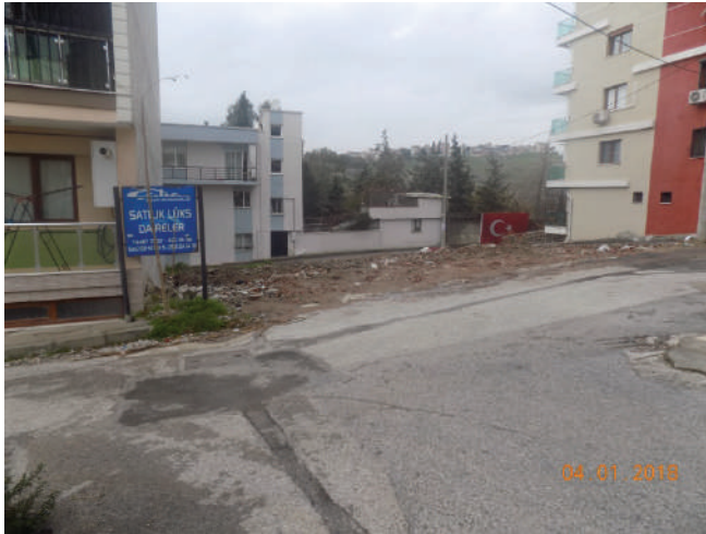
458 SOKAK NO 18 TESPİT VE YIKIMDAN "SONRAKİ" HALİ
