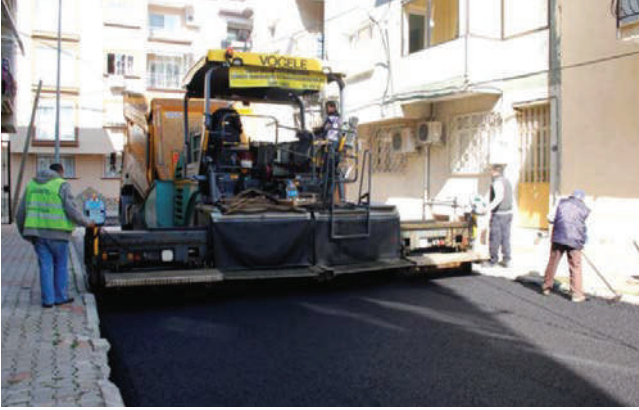
KOZAĞAÇ MAHALLESİ YOL BAKIM VE YENİLEME ÇALIŞMALARI
