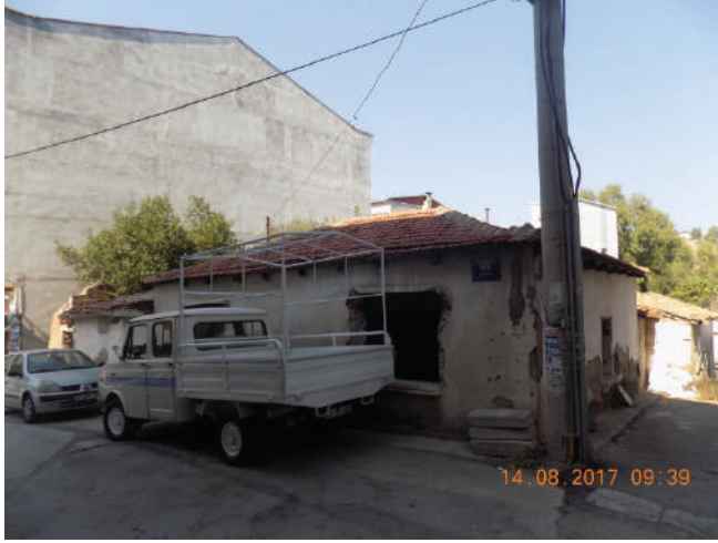
458 SOKAK NO 18 TESPİT VE YIKIMDAN "ÖNCEKİ" HALİ
