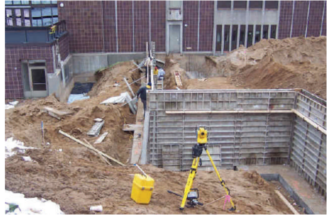
BUCA İLÇESİ TINASTEPE MAHALLESİ 40446 ADA 1 PARSEL TEMEL VİZESİ KONTROLÜ
