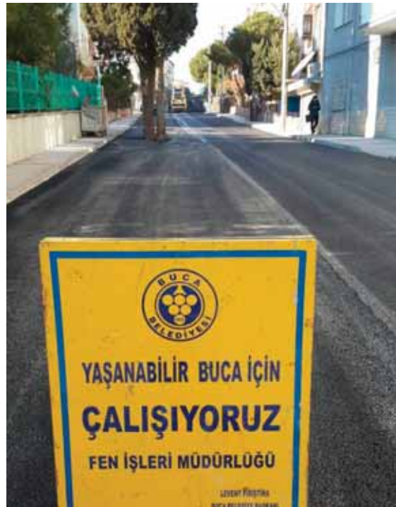
355 SOKAK ASFALT SERİM ÇALIŞMASI
