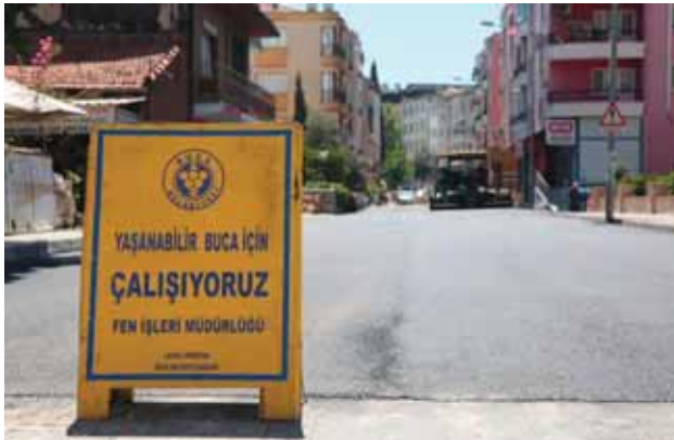
254 SOKAK ASFALT SERİM ÇALIŞMASI
