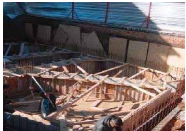
TEMEL APLİKASYON KONTROLÜ
